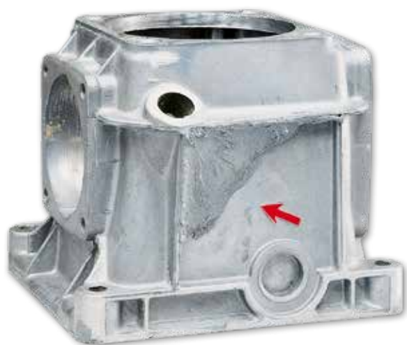
Alumínium burkolat felújítása
